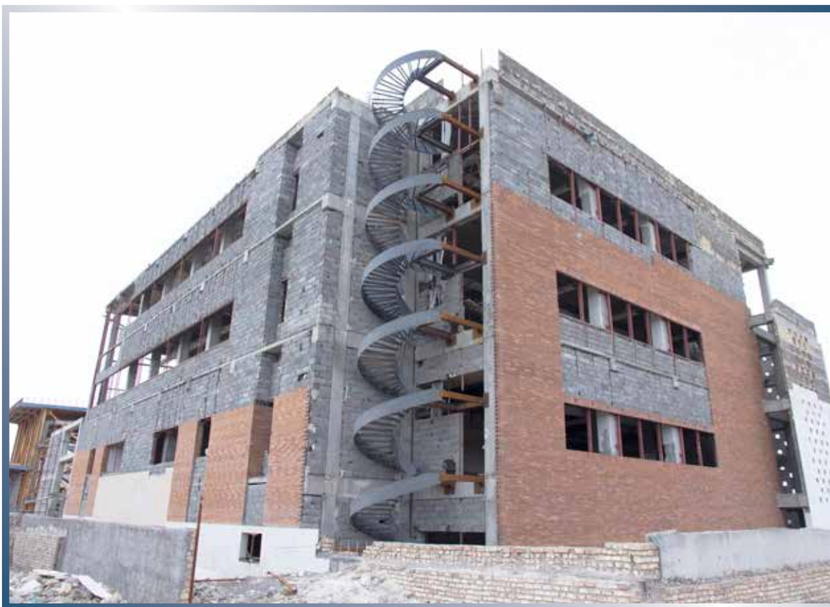
• ادامه عملیات ساختمانی کتابخانه مرکزی دانشگاه
